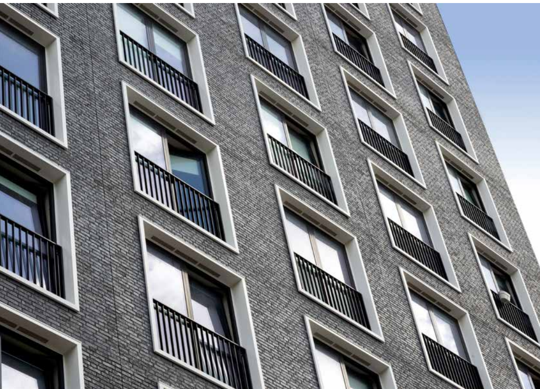
Het gebouw valt op door de kozijnen in een donkere tint en de dagkanten in het wit, wat zorgt voor verschillende accenten in elke gevel.
